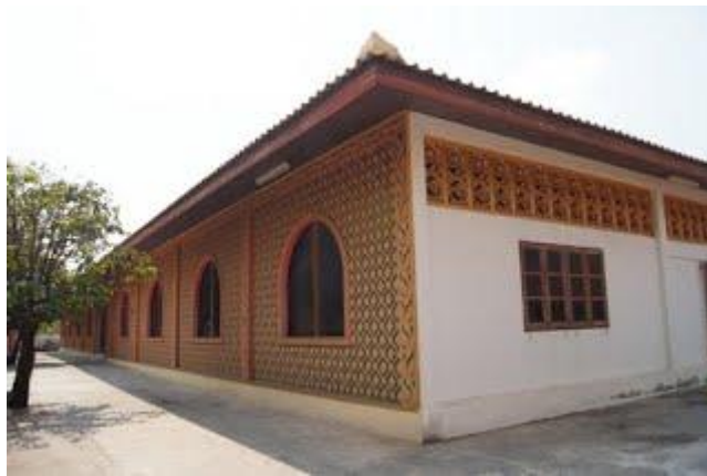
ศาลาเอนกประสงค์ กว้าง ๒๘ เมตร ยาว ๔๕ เมตร สร้างเมื่อ พ.ศ. ๒๕๔๒ เป็นอาคารคอนกรีตเสริมเหล็ก
