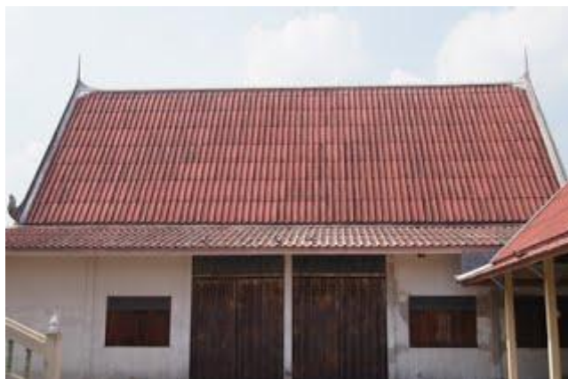
ศาลาบำเพ็ญกุศล จำนวน ๒ หลัง สร้างด้วยคอนกรีตเสริมเหล็ก ๒ หลัง นอกจากนี้ยังมี
