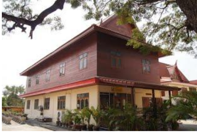
กุฏิสงฆ์ จำนวน ๓ หลัง เป็นอาคารครึ่งตึกครึ่งไม้ ๒ หลัง เป็นอาคารคอนกรีตเสริมเหล็ก ๑ หลัง
