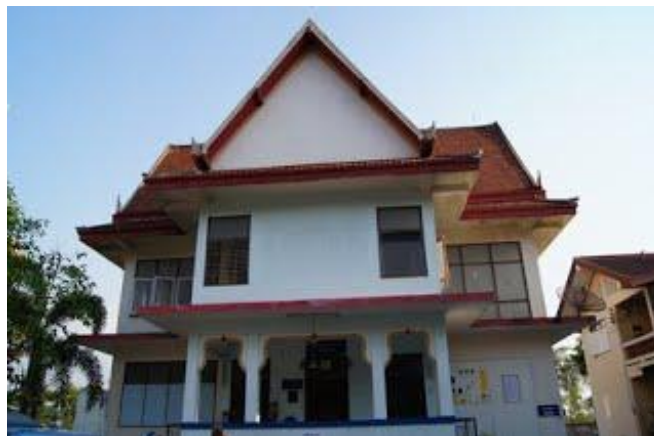
หอสมุด กว้าง ๑๐ เมตร ยาว ๑๕ เมตรเป็นอาคารคอนกรีตเสริมเหล็ก สร้างเมื่อ พ.ศ. ๒๕๒๙
