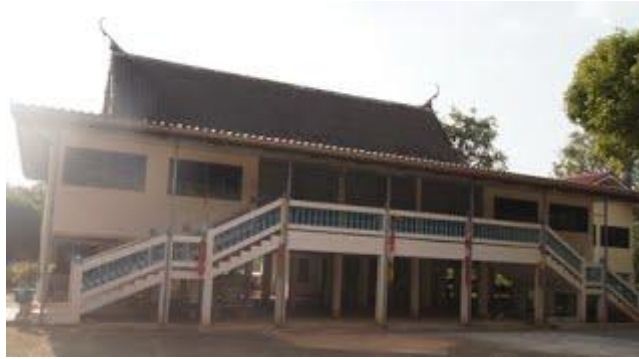
ศาลาการเปรียญ กว้าง ๑๑ เมตร ยาว ๒๓ เมตร สร้างเมื่อ พ.ศ. ๒๕๒๒ เป็นอาคาร ครึ่งตึกครึ่งไม้ ๒ ชั้น
