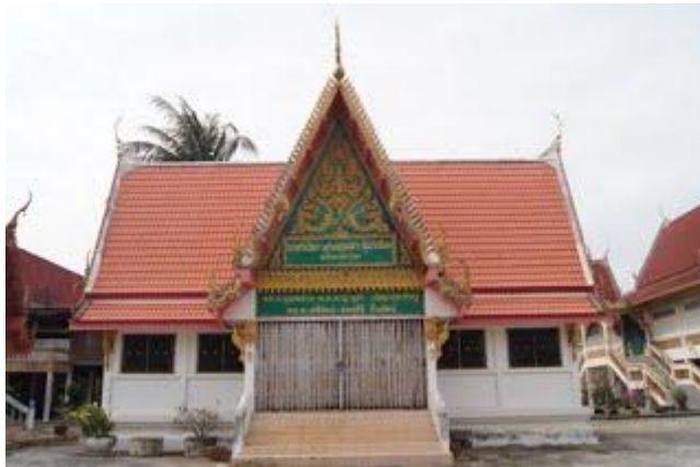
วิหาร กว้าง ๗ เมตร ยาว ๑๔ เมตร เป็นอาคารคอนกรีตเสริมเหล็ก สร้างเมื่อ พ.ศ. ๒๕๔๖
