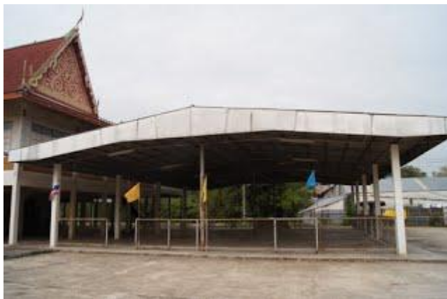
ศาลาเอนกประสงค์ กว้าง ๑๔ เมตร ยาว ๒๐ เมตร สร้างเมื่อ พ.ศ. ๒๕๔๔ เป็นอาคาร คอนกรีตเสริมเหล็ก
