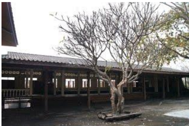
ศาลาอเนกประสงค์ กว้าง ๑๒ เมตร ยาว ๒๒ เมตร สร้างเมื่อ พ.ศ. ๒๕๔๗ เป็น อาคารคอนกรีตเสริมเหล็ก โครงเหล็กเทพื้นคอนกรีต
