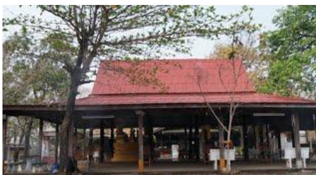
ศาลาอเนกประสงค์ กว้าง ๑๒ เมตร ยาว ๒๒ เมตร สร้างเมื่อ พ.ศ. ๒๕๔๗ เป็น อาคารคอนกรีตเสริมเหล็ก โครงเหล็กเทพื้นคอนกรีต
